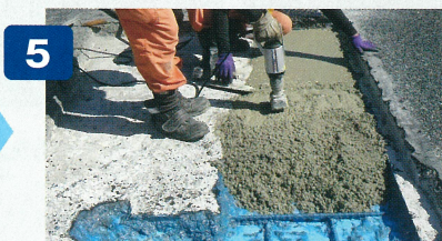
コンクリート打設
