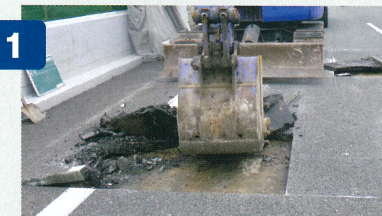
既設アスファルト舗装撤去
