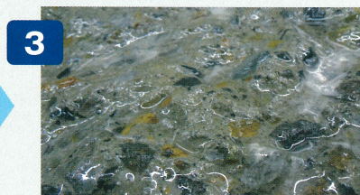
浸透性KSプライマー塗布
