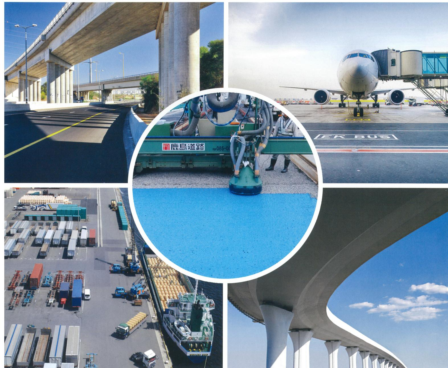
**KSボンドタイプMは、鋼材またはコンクリートを被着体としたフレッシュコンクリートの打継ぎに用いる高耐久型エポキシ系接着剤です。従来のKSボンドよりも可使時間を長くしているため、大面積での施工が可能です。また、専用の塗布装置にて、主剤と硬化剤の自動混合および吹付け塗布による均一施工も可能です。**
