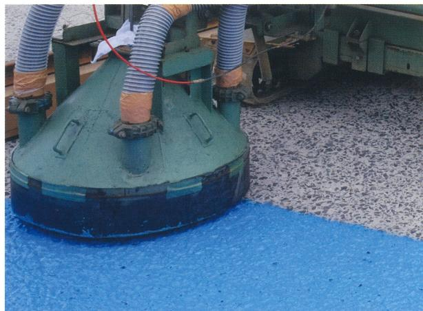
吹付け部は、カバーにて飛散防止をしています。
