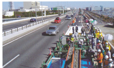
鋼床版上SFRC補強工法 首都高速道路(株)湾岸線、中央環状線(2007年～)
