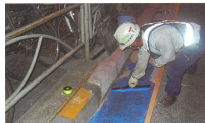
超速硬コンクリート街渠嵩上げ工法 国道254号線 春日一丁目(2006年)
