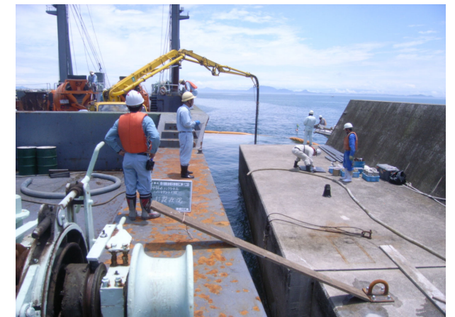
4. ハイドロコンクリート打設状況
