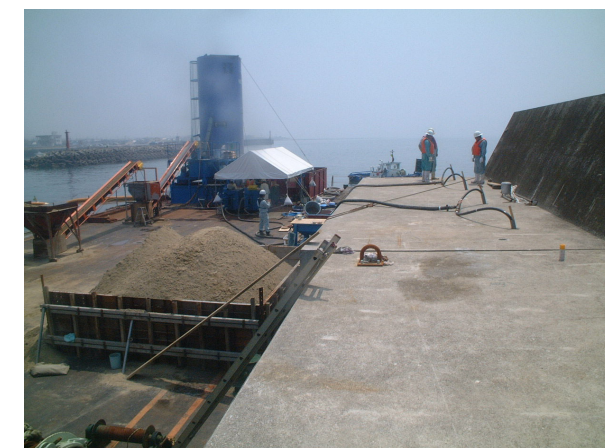
5. ハイドロモルタル充填状況
