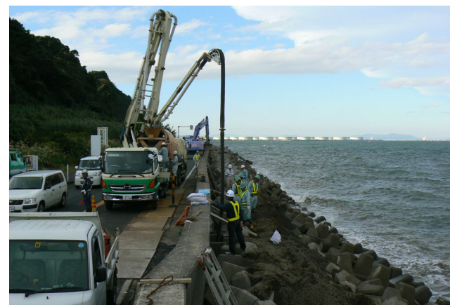
②打設状況(1)
