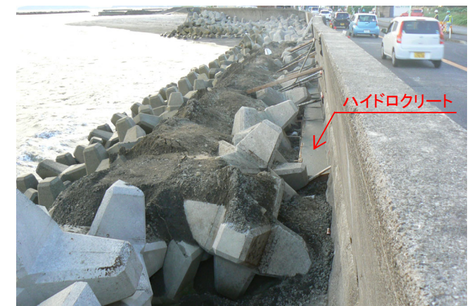
⑤打設完了
