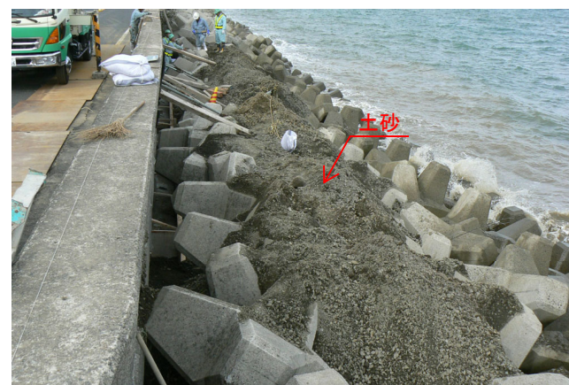
①型枠用土砂投入
