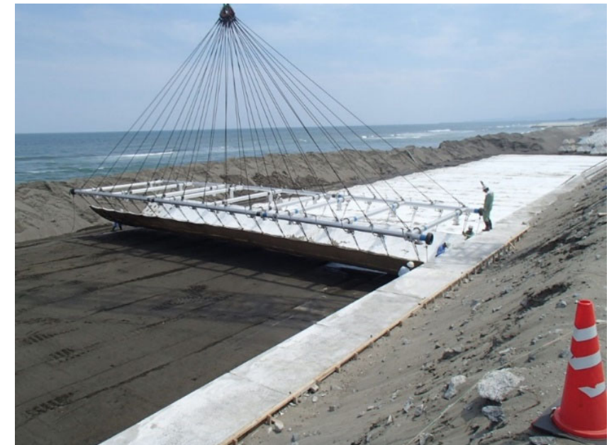
敷設状況 ②
