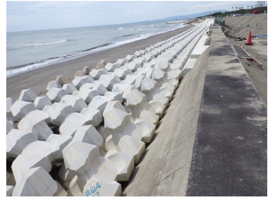
完成 北側から
