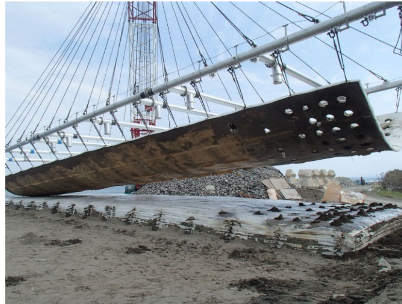
敷設状況 ①
