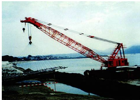
As マット敷設状況（H3年施工）
