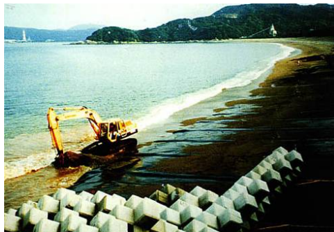
As マットのたわみ込み促進（H3年施工）
