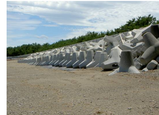
改良断面の現況 （H18年施工，H19年調査）
