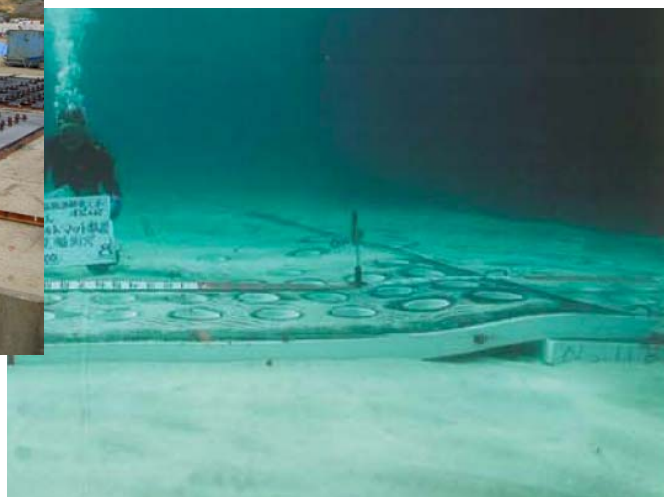
敷設後の孔あきアスファルトマット
