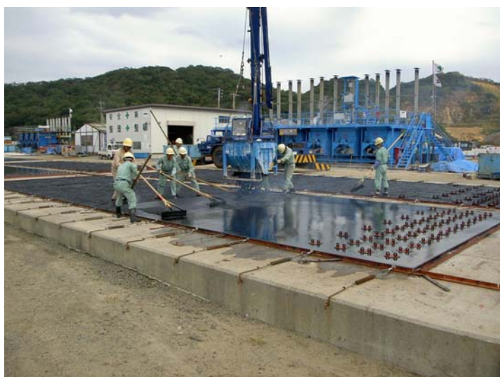
孔あきアスファルトマット製作状況
