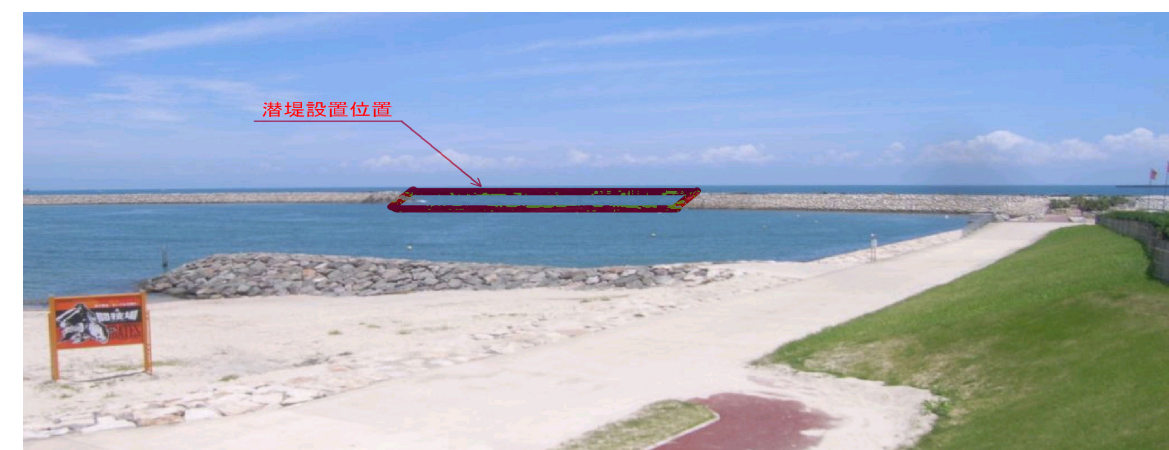
潜堤完成後の状況(北潜堤)
