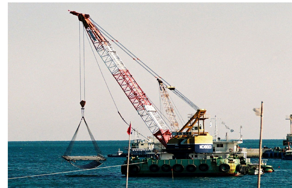
アスファルトマット敷設状況
