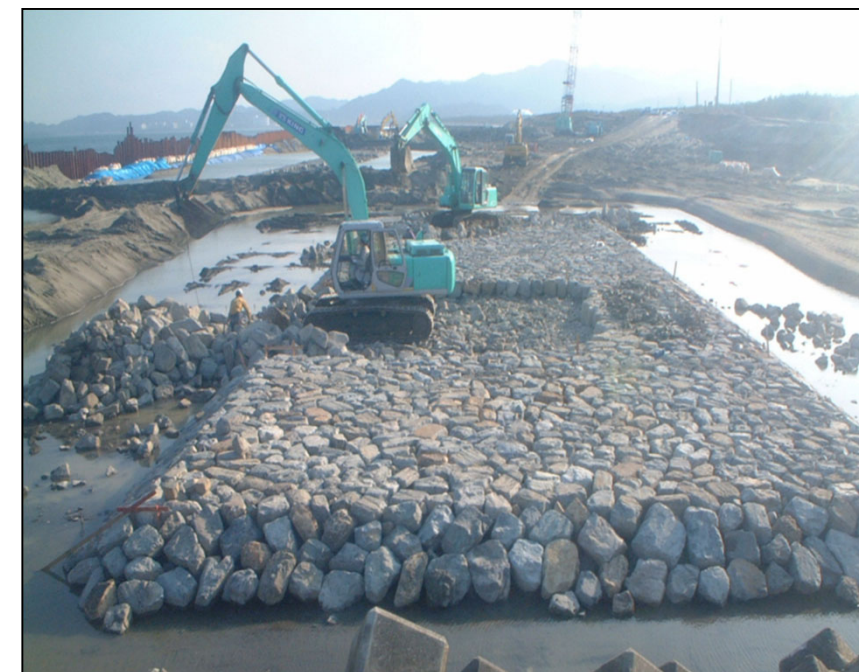
写真-3 基礎捨石設置状況
