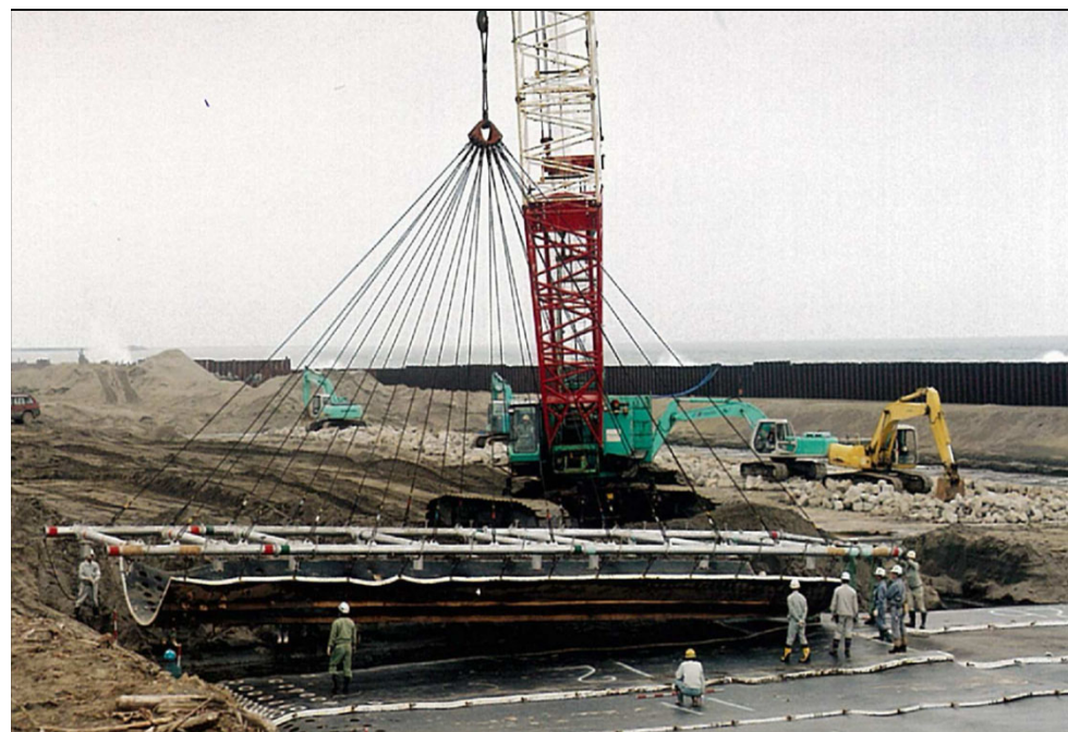
写真-1 アスファルトマット敷設状況
