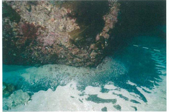
アスファルトマットにシェークブロック(50t)が上載されている。
