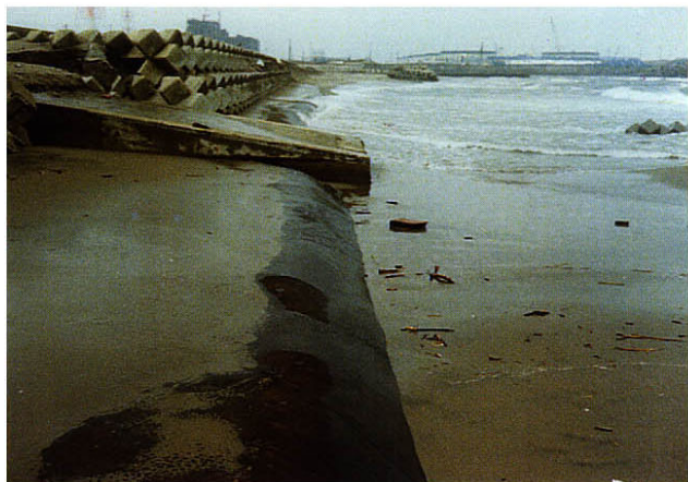
護岸 (昭和43年施工)
