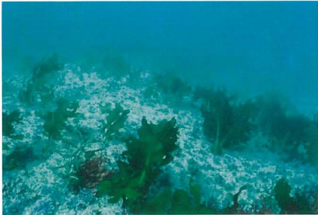
アスファルトマット上に海藻が植生している。
