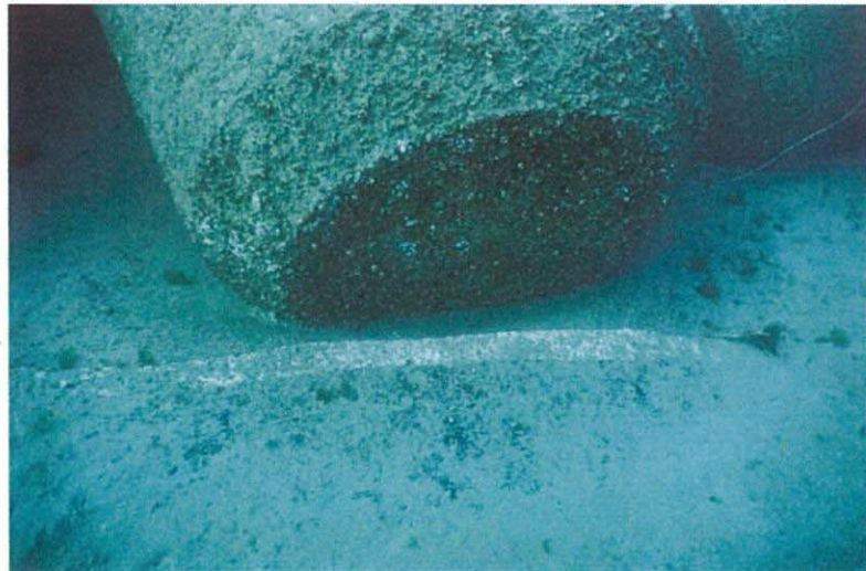
アスファルトマットにテトラポッド(40t)が上載されている。
