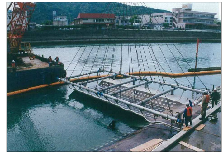
フィルターシート付 孔あきアスファルトマット敷設状況(アスファルトマット上面)
