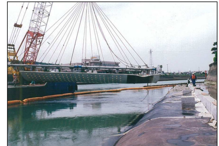
フィルターシート付 孔あきアスファルトマット敷設状況 (アスファルトマット下面)
