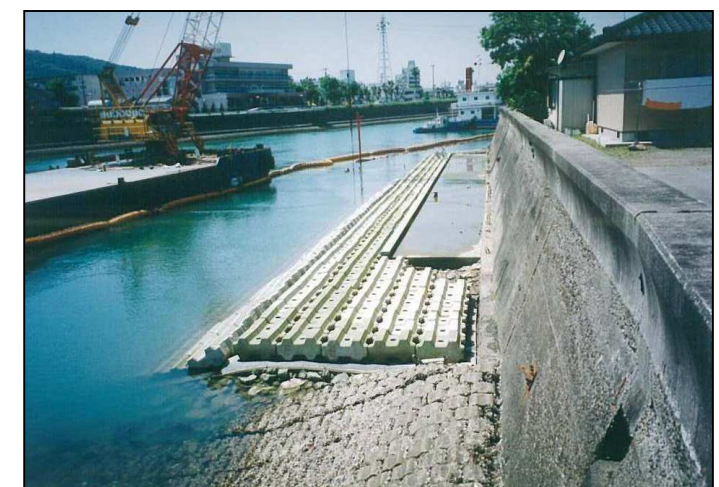
被覆ブロック設置後の護岸全景
