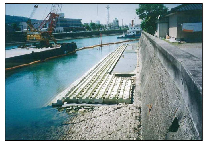
被覆ブロック設置後の護岸全景
