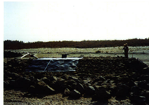
写真-2 塩化ビニルマット敷設
