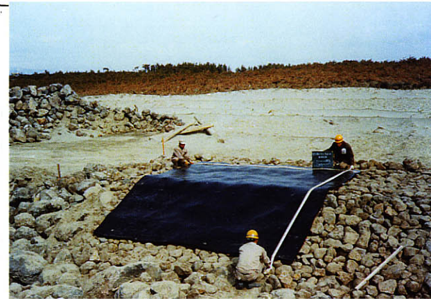
写真-1 アスファルトマット敷設
