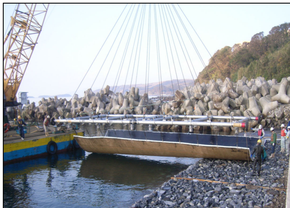
アスファルトマット敷設状況
