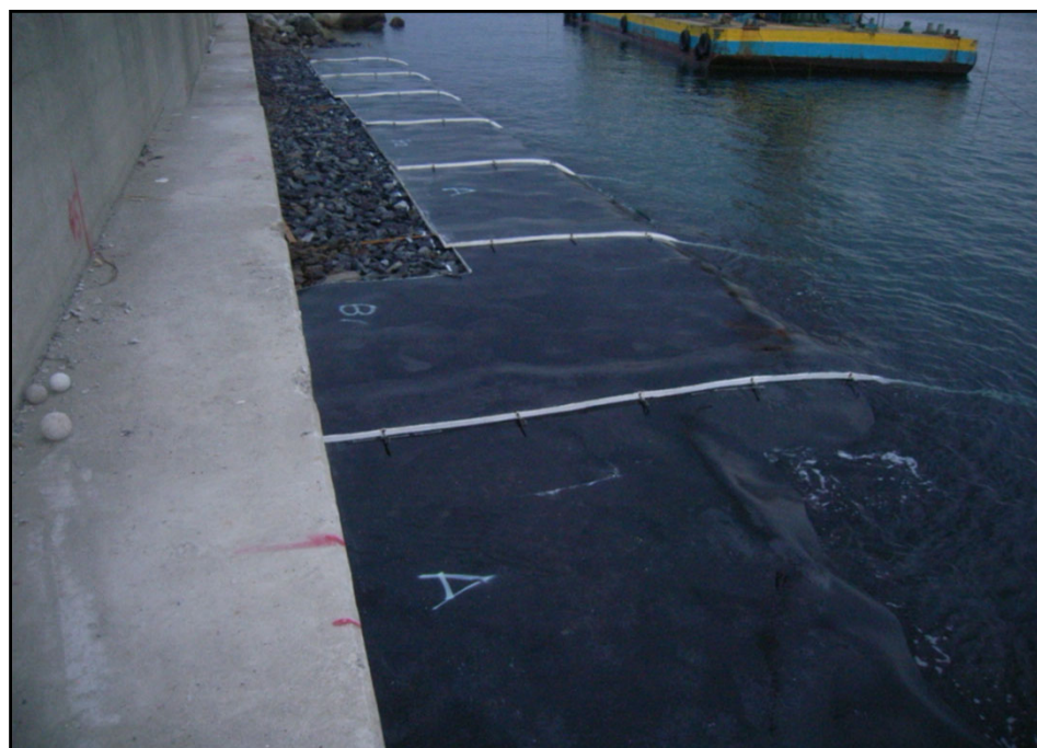
アスファルトマット敷設完了
