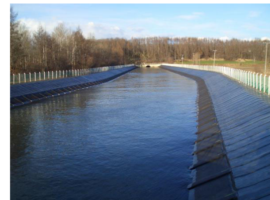
導水路補修工事後
