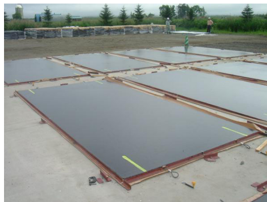
アスファルトマット製作
