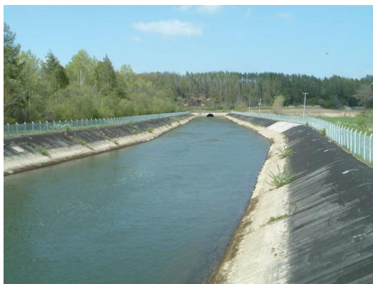
導水路補修工事前
