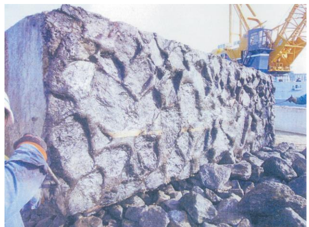
図-4 現地のアスファルトマットがケーソン下面に付着している様子
