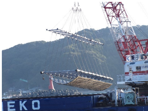
アスファルトマット敷設状況① (スネーク吊金具使用)
