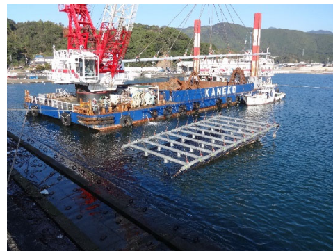
アスファルトマット敷設状況② (スネーク吊金具使用)
