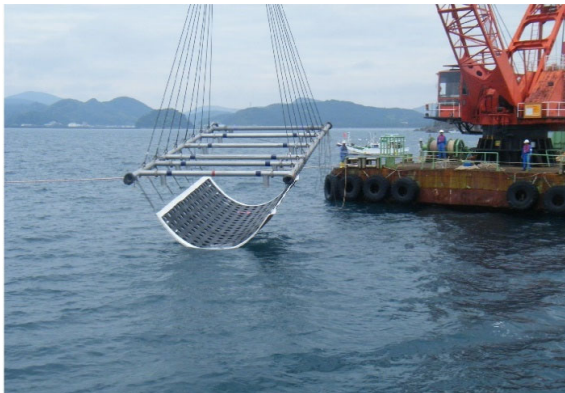
アスファルトマット敷設状況①
