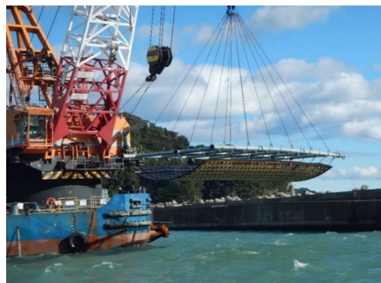
アスファルトマット敷設状況
