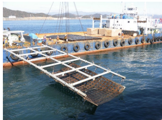
アスファルトマット敷設状況
