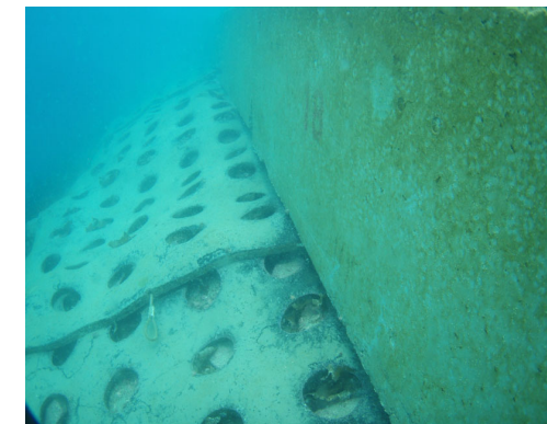
アスファルトマット敷設後の状況
