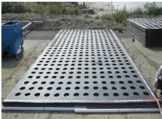
洗掘防止用全面孔あき強化アスファルトマット
