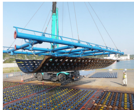
アスファルトマット吊り上げ状況
