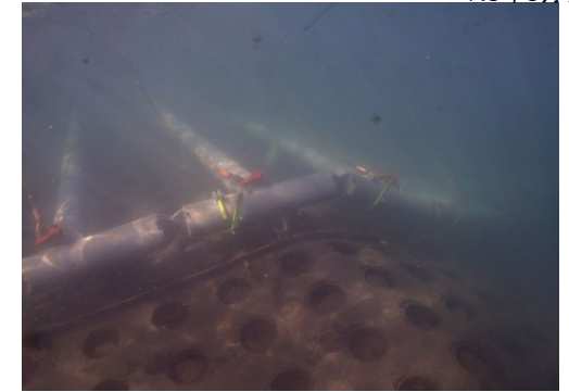
アスファルトマット敷設状況(水中)④ (スネーク吊金具使用)
