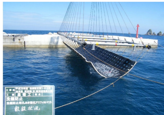
アスファルトマット敷設状況②
