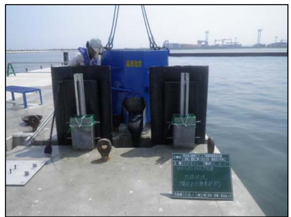
筒状遮蔽部アスファルトマスチック充填
