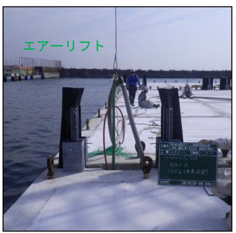
アスファルトマスチック充填前目地内清掃
