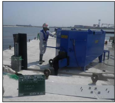
筒状遮蔽部アスファルトマスチック充填
