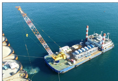
アスファルトマスチック打設状況
