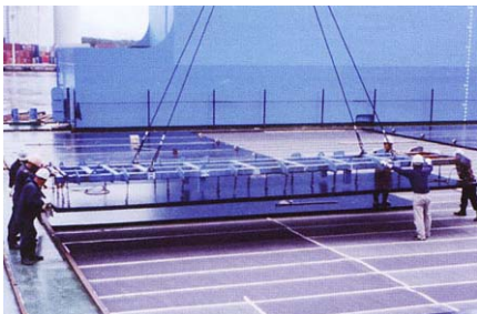
アスファルトマット敷設
